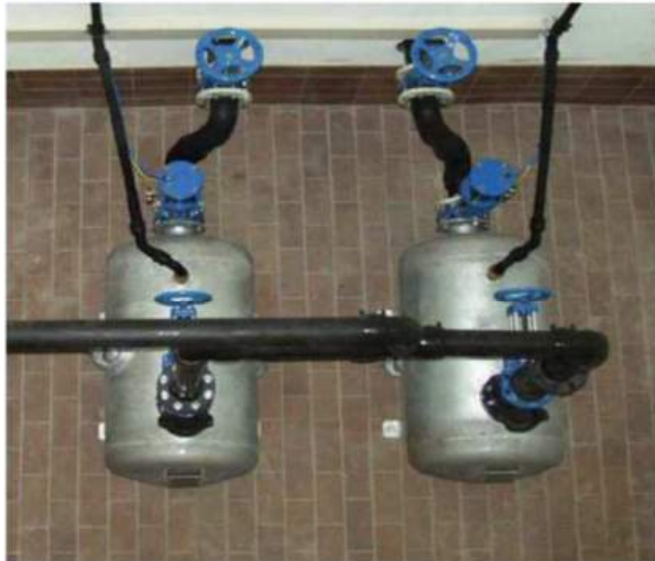
Arbeitsbehälter mit Armaturen und Rohrleitungen
