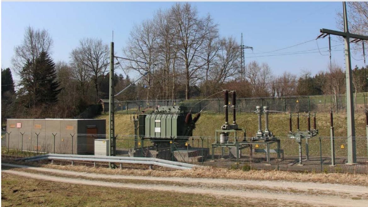
Das Unterwerk in Geltendorf wandelt den Bahnstrom mit 110-Kilovolt in Strom für die Oberleitungen mit 15-Kilovolt Spannung um.
